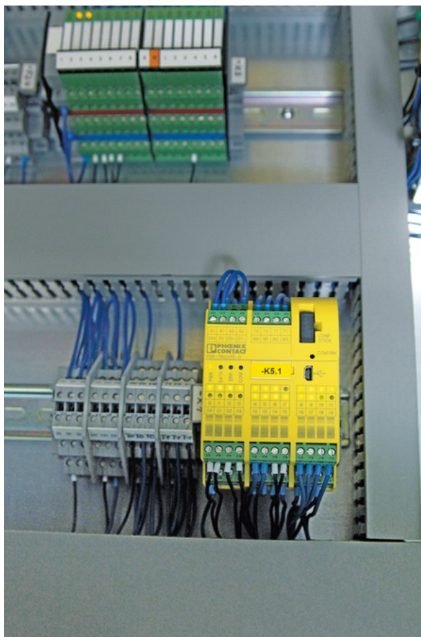
Sicherheitsmodul PSR-TRISAFE bei huw im Einsatz
