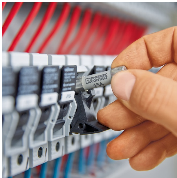
Jeder String wird einzeln abgesichert
