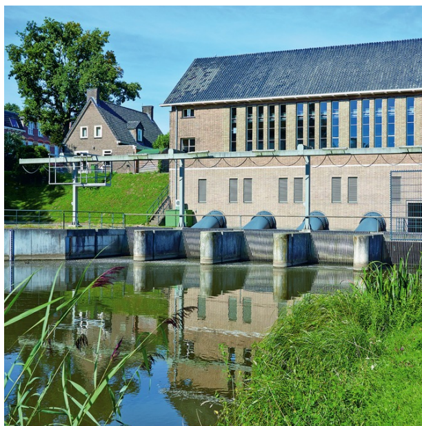
Station de pompage de Nimègue
