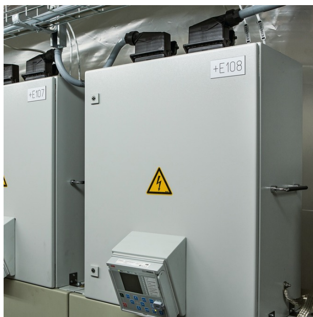
Connecteur Heavyconnec Evo pour raccordement à une armoire électrique
