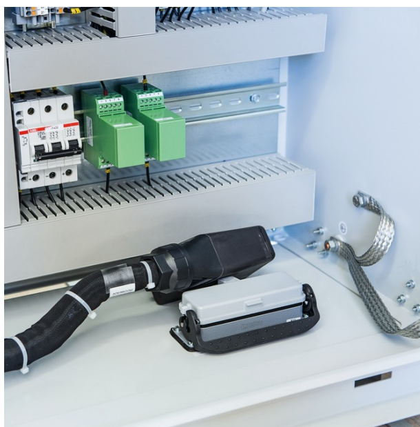
Le verrouillage à étrier rend le raccordement plus simple et sûr
