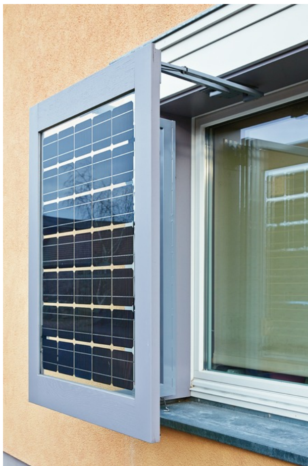
As portadas fotovoltaicas podem ser rodadas paralelamente à janela
