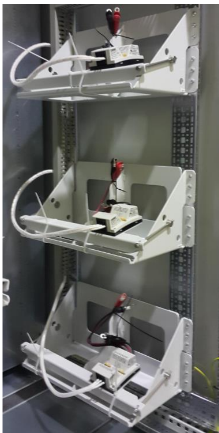
Рисунок 3 – Крепление АКБ на вибростойкой BATTERY MOUNTING CASE
