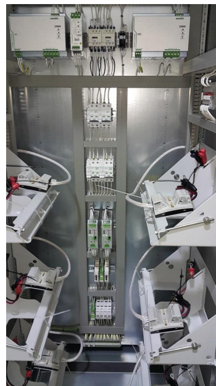
Рисунок 2 – организация бесперебойного питания с помощью серии Quint
