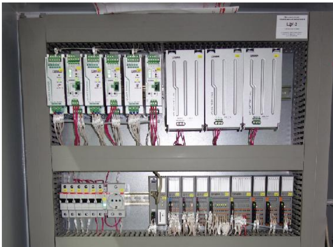
Рис. 2. Питание шкафов управления устройствами семейства QUINT
