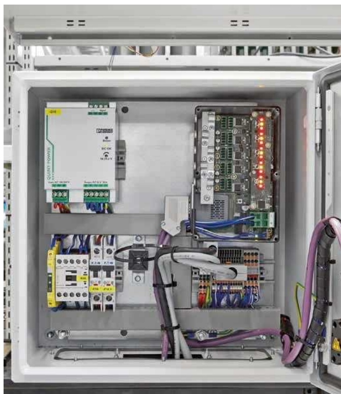
◀ Das unten links im Schaltkasten montierte Sicherheitsrelais PSRmini spart bis zu 70 Prozent Platz ein.
